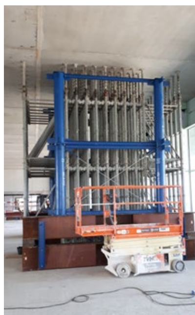
8 Systeem voor het opvangen van de kolombelasting, stempels nog aanwezig
