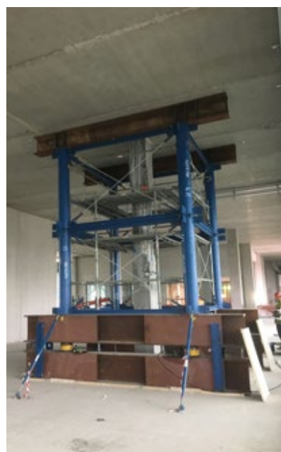
9 Systeem na verwijderen stempels
